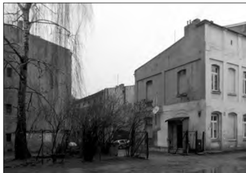
Widok budynków na posesji przy ul. Nowej 5 w Łodzi.
